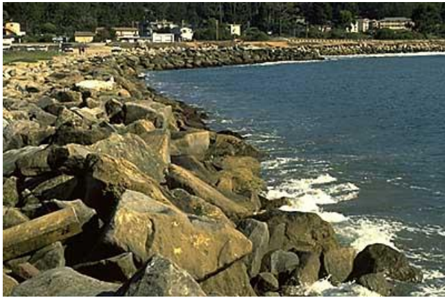
Figure A16: ESI 6B: Riprap
