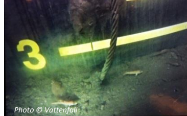
Photo © Vattenfall Suction bucket trial at Vattenfall Aberdeen OWP
